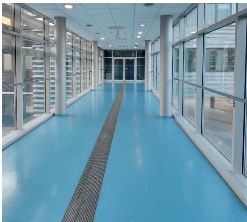
Obr. č. 1: Využití vodící linie uvnitř budovy pro orientaci osob se zrakovým postižením.
