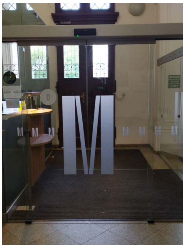
Obr. č. 8: Příklad alternativního vyznačení prosklené plochy.
