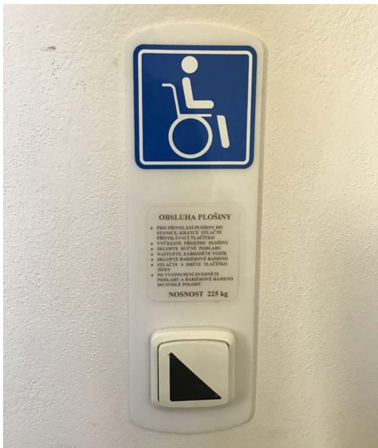
Obr. č. 14: Popis ovládání plošiny v nástupním bodě
