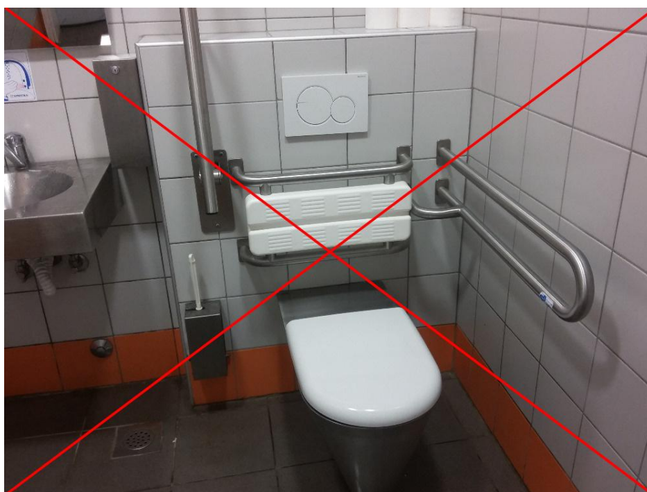
Obr. č. 10: Příklad vhodného umístění zádové opěrky integrované do madel WC.
